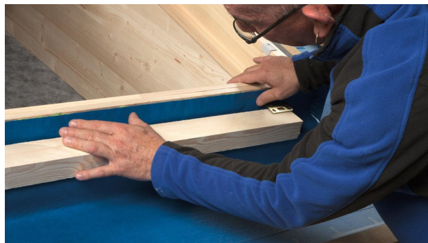
8. SOLITEX WELDANO-S 3000 mit Dehnschleife in das Kleberbett legen. Kleber dabei nicht ganz flach drücken, damit ggf. Bewegungen aufgenommen werden können.
