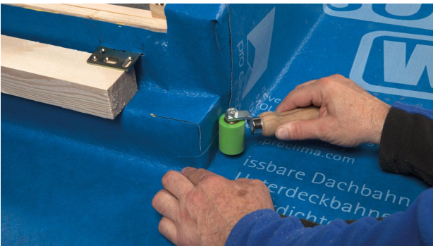
29. SOLITEX WELDANO 3000 Streifen anschweißen.
