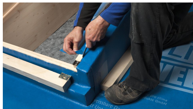
18. Parallel zum Fensterrahmen zuschneiden. Hierbei hilft eine Hilfsplatte zur faltenfreien Fixierung der unteren Kante.
