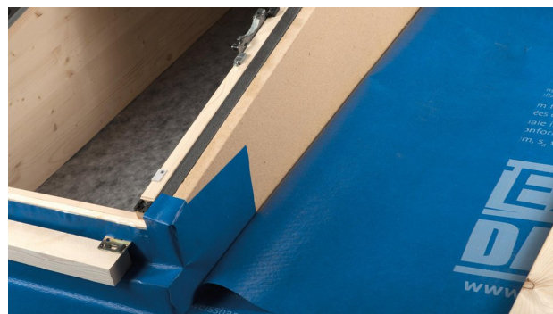
16. Fertige untere Eckabdichtung.
