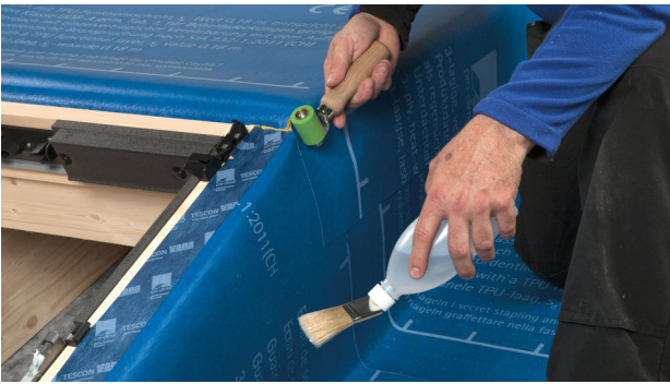
25. Seitlich die Lagen SOLITEX WELDANO 3000 miteinander verschweißen.
