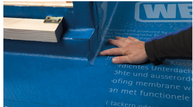
28. Auf wasserführende Bahnenüberlappung achten.
