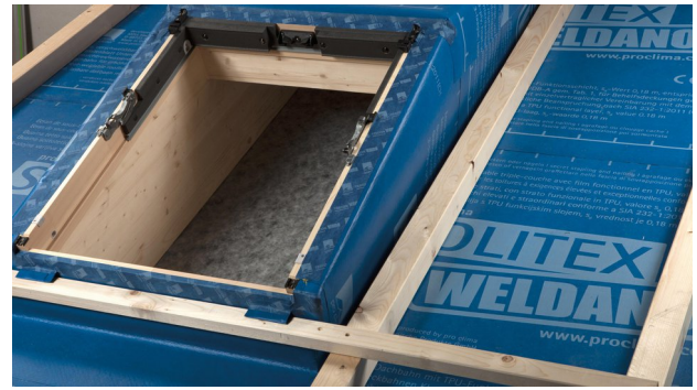
34. Konterlatten und Traglatten montieren und Montagewinkel verschrauben. Fertig.
