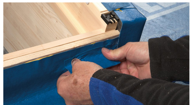
32. Montagewinkel einschweißen.
