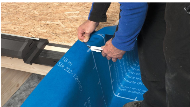
17. Seitlich am Aufkeilrahmen die Bahn aus der Fläche hochführen. Alternativ einen neuen Streifen SOLITEX WELDANO 3000 ablängen, am Aufkeilrahmen hochführen und unten auf der flächigen Bahn schweißen.
