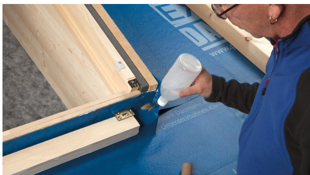
9. Zuvor gefaltete Ecke verschweißen.
